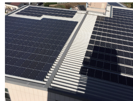
太陽光パネルの設置
